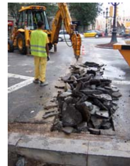
6. Obertura de la rasa
