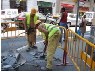
1. Inici de la cala
