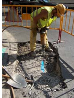
2. Vista de les canalitzacions de serveis
