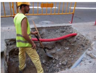
1. Rebaix de la cala
