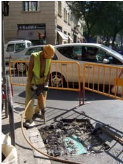
1. Rebaix de la cala
